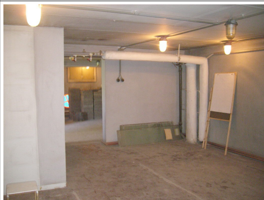
Veetorud on võimalike vigastuste ja külmumise vastu paksult isoleeritud
